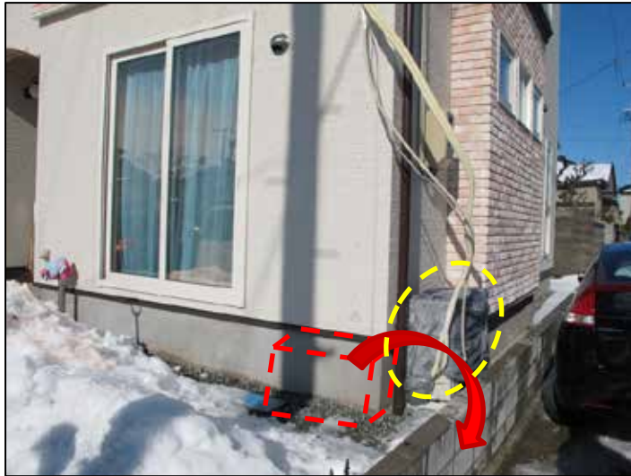
東側に転倒したエアコン室外機 (南南東から撮影 [復旧後])
