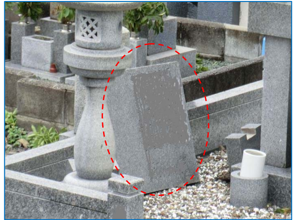
写真④ 撮影方向 西南西 東方向に倒れた墓碑
