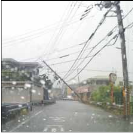
写真 六条2丁目 傾いた電柱
