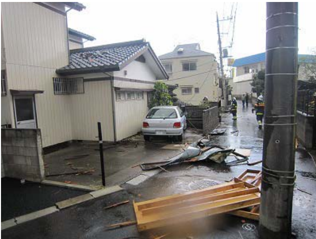
③倒壊したプレハブ建屋の飛散物と飛散物による瓦の破損（東から撮影） 【取手市消防本部提供】
