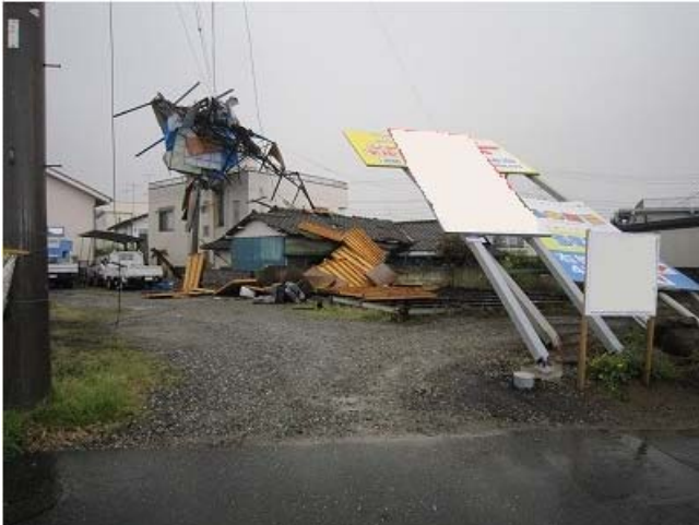
①傾いた看板と倒壊して吹き飛んだプレハブ建屋（北西から撮影） 【取手市消防本部提供】
