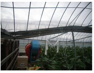
写真② 支柱が持ち上げられたため屋 根も上向きに持ち上げられて いる
