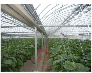
写真④ 支柱と屋根が持ち上げられて いないハウス内の様子
