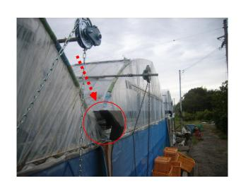
写真⑦ 屋根のビニールを開閉する滑車(チェーンブロック)が矢印方向に落下して雨樋、滑車が損傷した(滑車は新品に交換済み)
