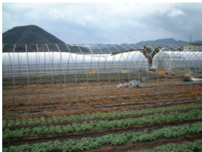
写真3 変形したビニールハウス
