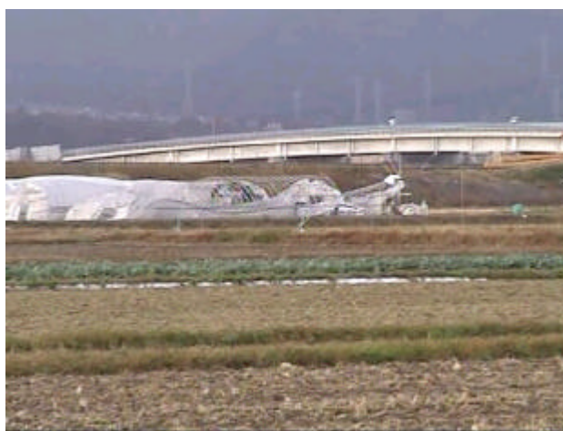
写真1 被害を受けたビニールハウス
