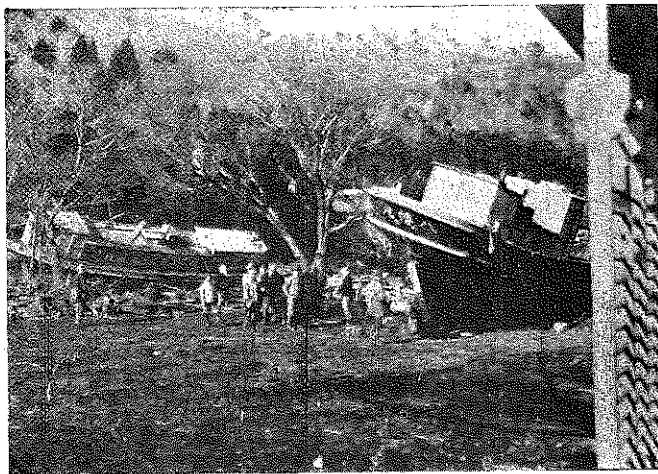
昭和8年3月3日の三陸大津浪の時澤山の漁船が陸地に打上げられました。これはその中の一つ、宮城縣雄勝で海岸から200米も離れた國民學校の校庭へ打上げられたものです。(本文24頁をごらん下さい)
