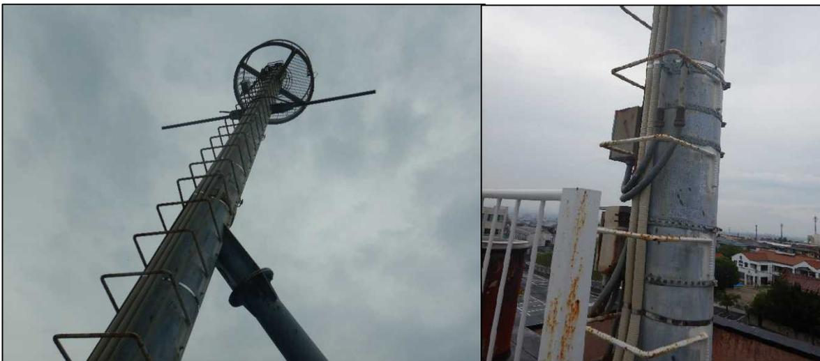
■ 日照計架台の手すり、昇降階段に錆が発生している
