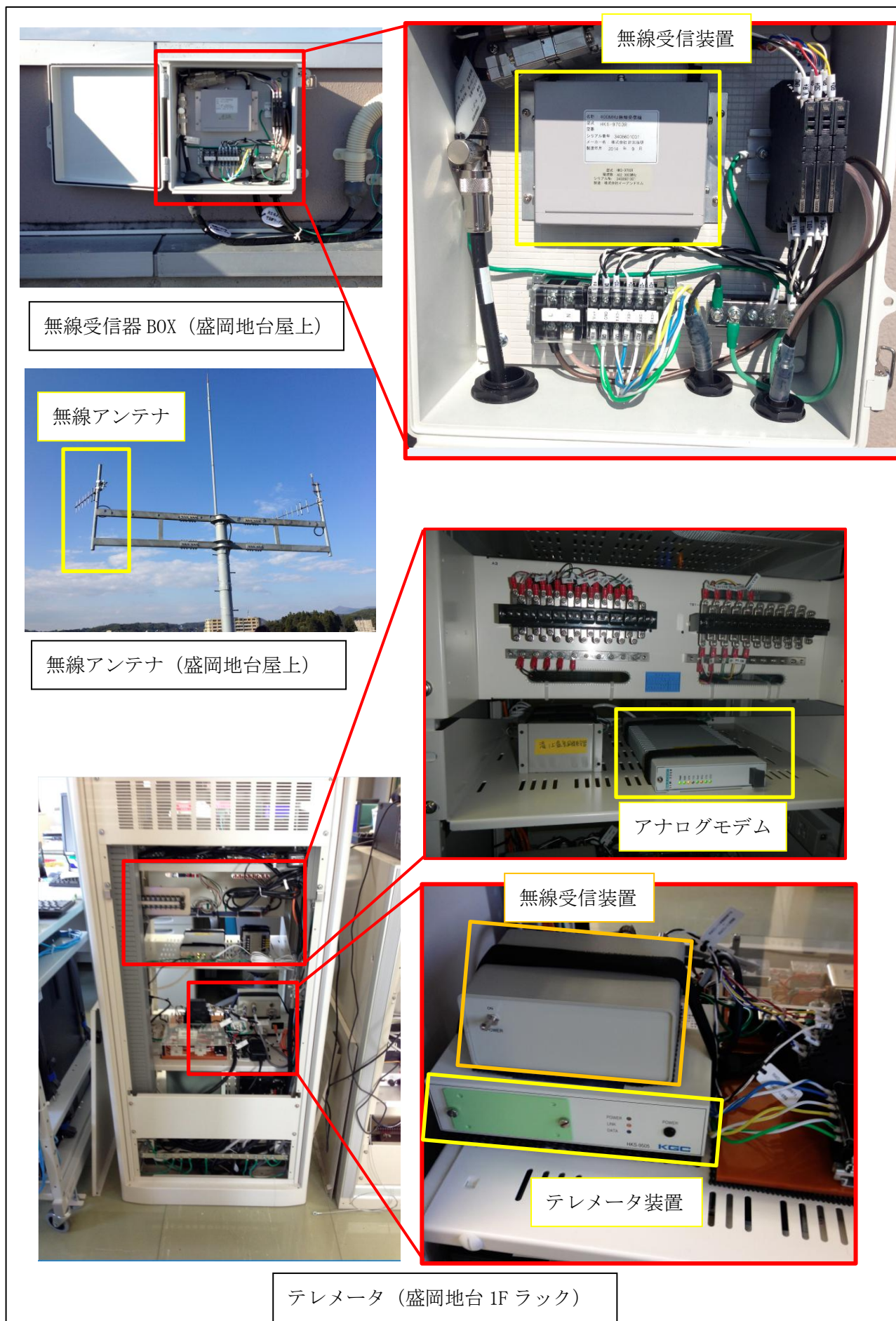
図 4 滝ノ上温泉・八合目小屋受信施設 (盛岡地方気象台内) 機器図
