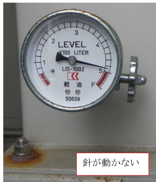
写真2 液面計及び付属バルブ（正面）
