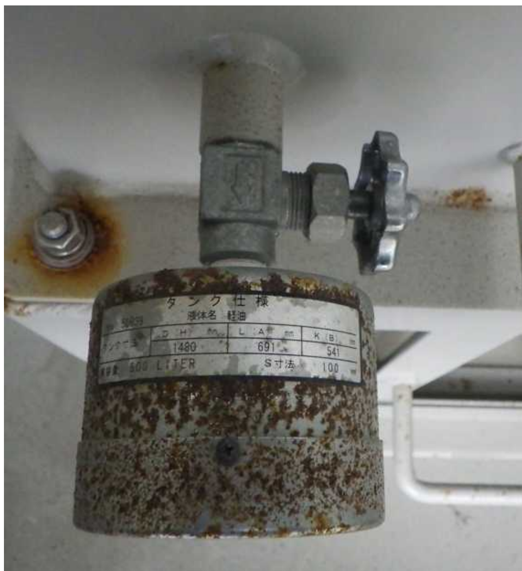
写真3 液面計及び付属バルブ（上から）
