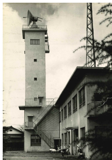
新設したレーダー塔
