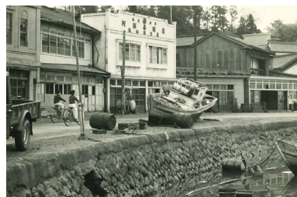
打ち上げられた漁船 (現・気仙沼市)
