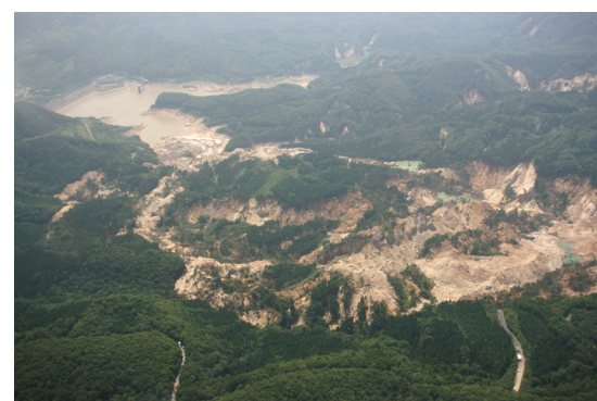
荒砥沢ダム周辺の大規模崩壊 （栗原市）
