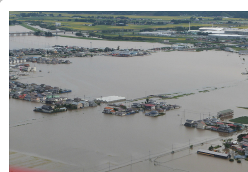
大崎市の冠水 （仙台市消防局提供）
