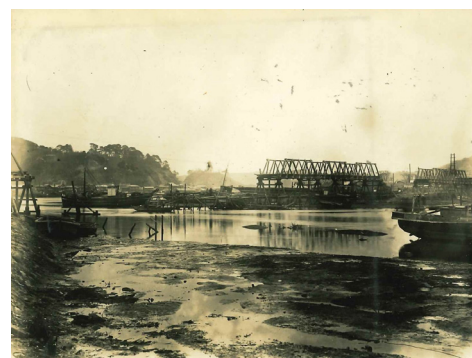
流失した宮古橋 (現・岩手県宮古市)
