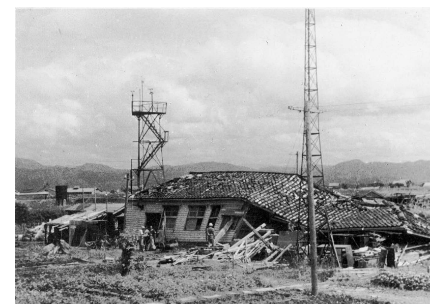
福井地震で倒壊した福井測候所 （福井地方気象台HPより）
