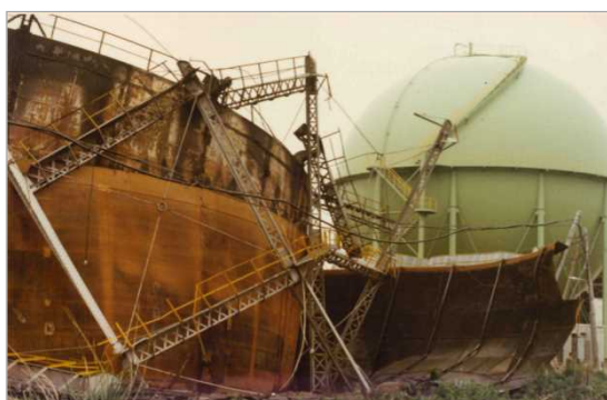
炎上倒壊したガスホルダー (現仙台市宮城野区幸町)
