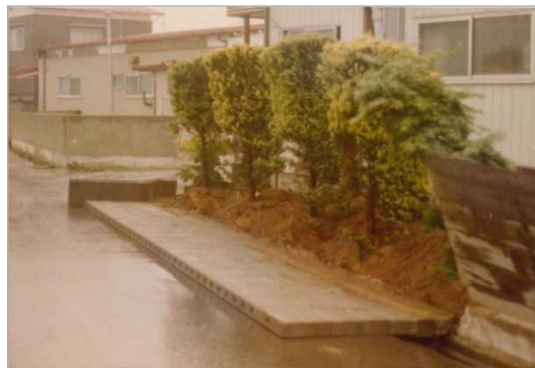
倒壊したブロック塀（石巻市）
