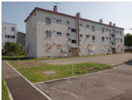
札幌管区気象台構内宿舎
