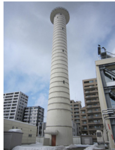
気象レーダー塔
