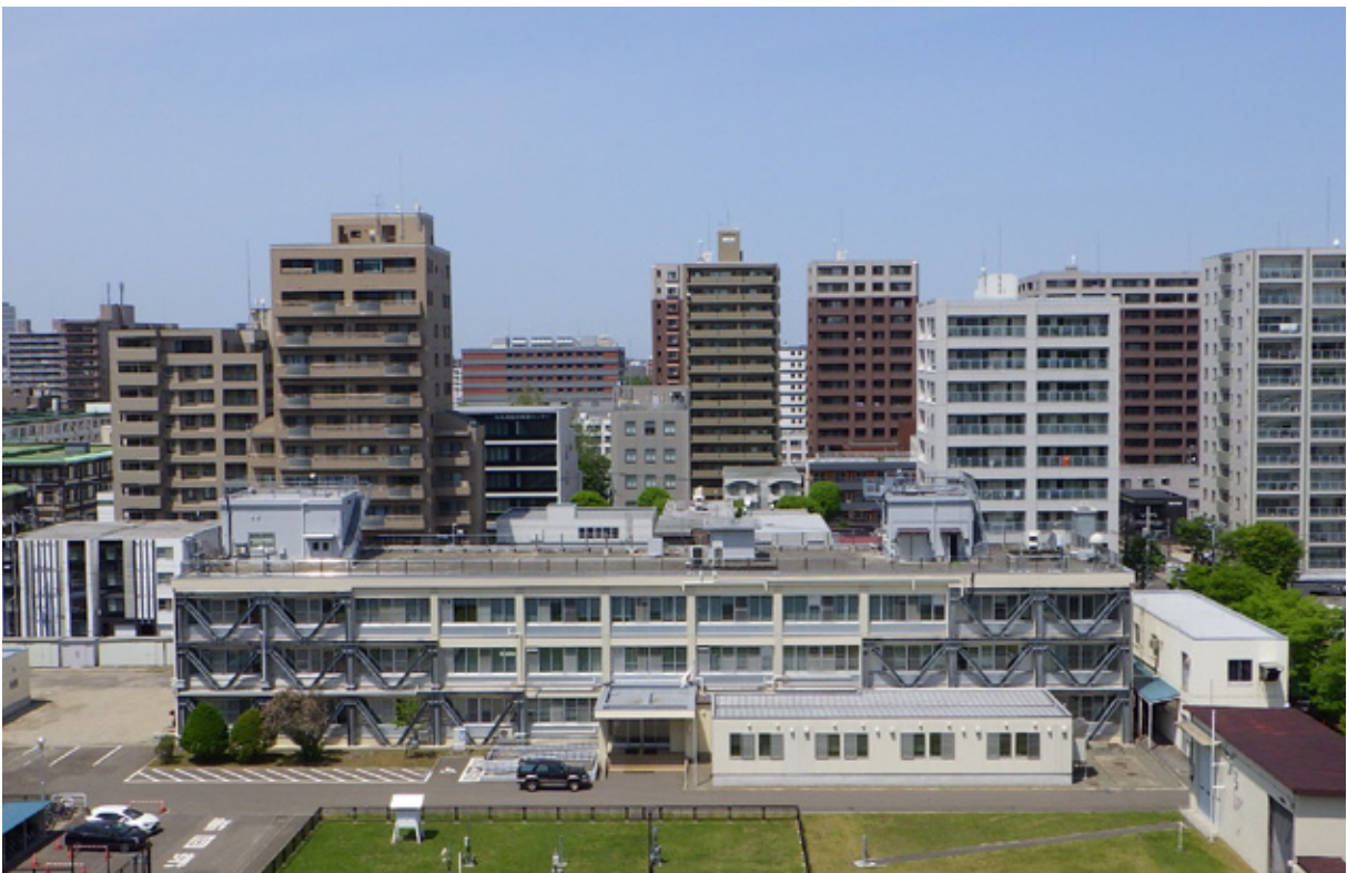
札幌管区気象台庁舎全景
