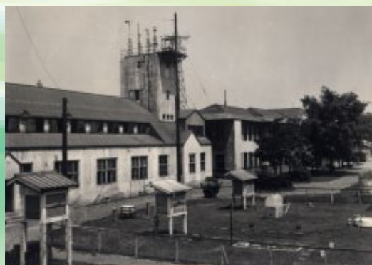
昭和34年頃の札幌管区気象台 (札幌市中央区北2条西18丁目)
