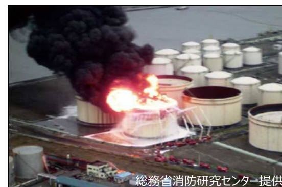
石油タンクの被害
