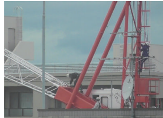
クレーンを検査する様子【北海道労働局】
