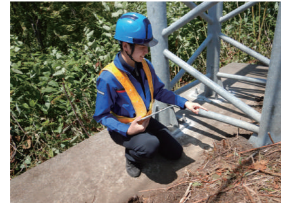
警察通信施設の機能・性能を良好な状態に維持するため点検している様子 [北海道警察情報通信部]
