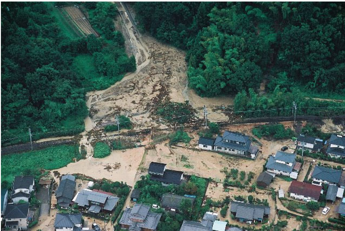
新居浜市郷：土石流により線路が埋没した JR 予讃線 (提供：愛媛県警察本部)
