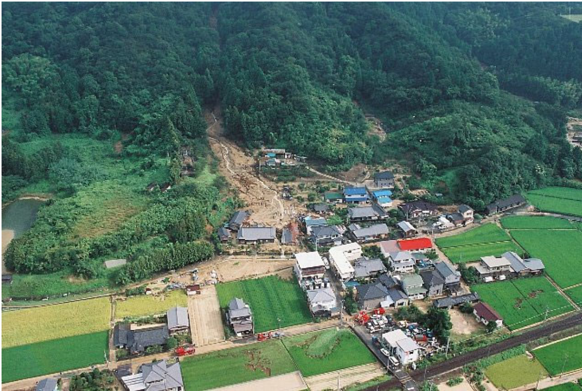
新居浜市神郷：土砂で倒壊した家屋の下敷きとなり2名が死亡した現場 (提供：愛媛県警察本部)
