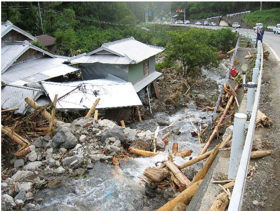
徳島県上那賀町海川地区の土石流被害
