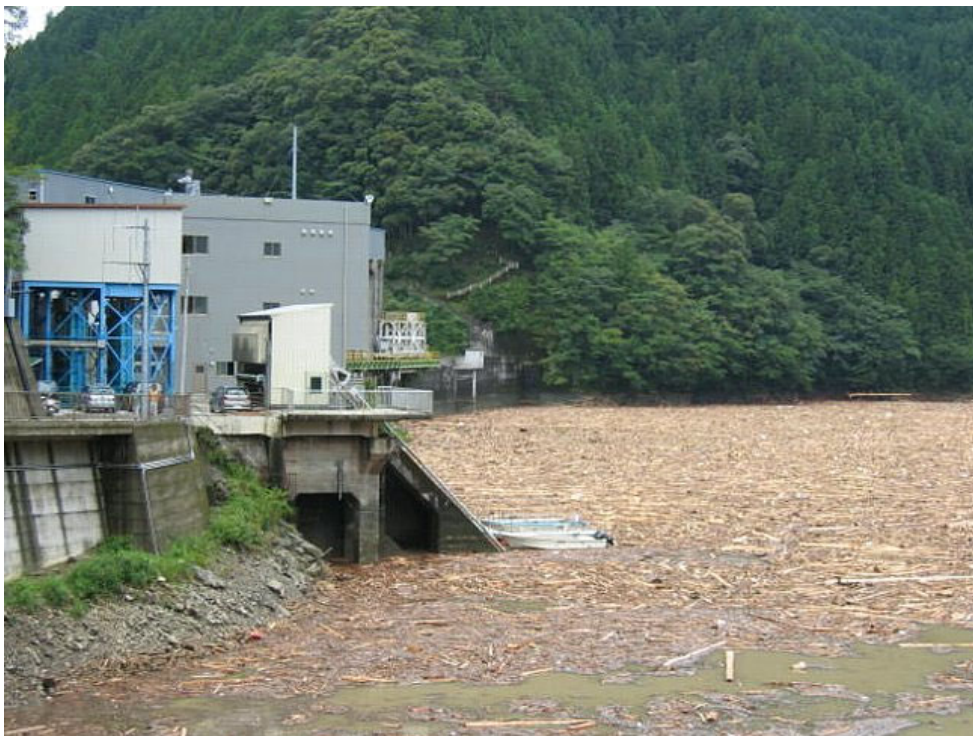
徳島県上那賀町長安口ダムに流れ込んだ流木
