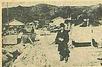
牟岐町海岸通りの被害
