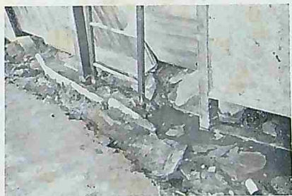
(沈下セル地盤ニ涌水アリ)
