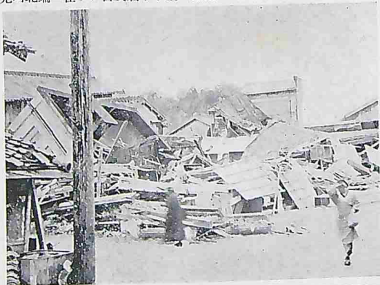
元町北端 = 在リッ百貨店丁字屋ノ崩壊 (四圍ノ家相對的 = 健全)
