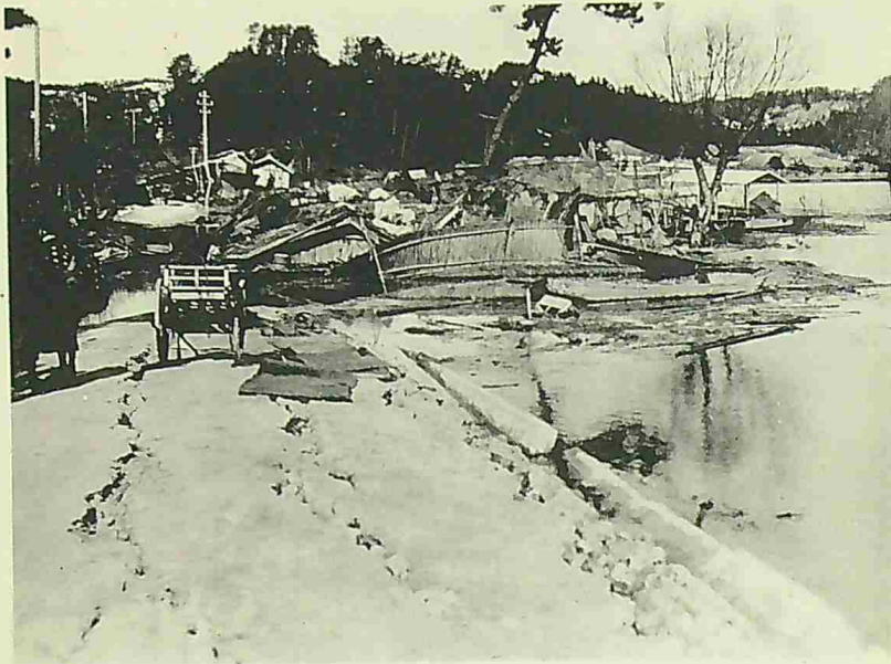
竹野郡小濱村離湖ノ陥没状況
