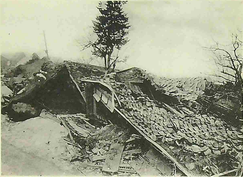
一家六名壓死セル與謝郡山田村山崎八左衛門邸 宅倒壊狀況
