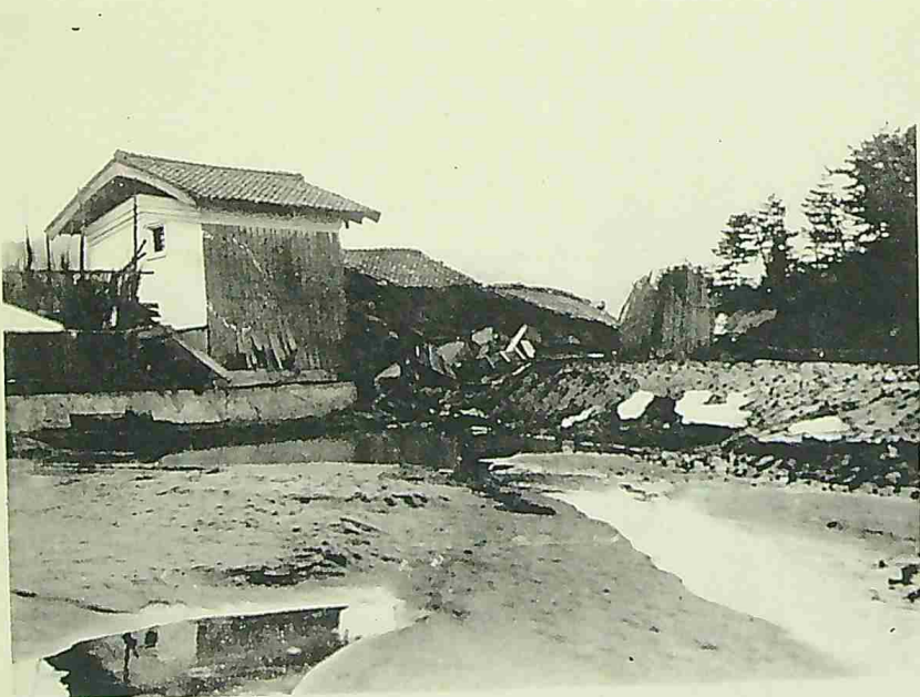
竹野郡木津村上野田面隆起陥没ノ状況
