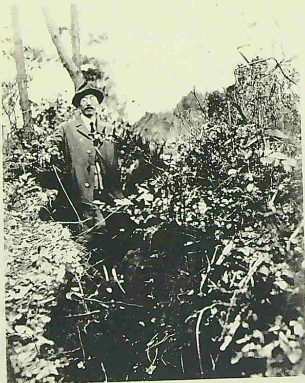
竹野郡網野驛南方ニ位セル山ノ頂上ヲ走レル大亀裂状況(巾二尺餘深サ腋下ニ及ブ)
