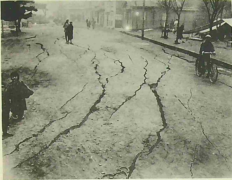
與謝郡宮津町海岸龜裂ノ狀況
