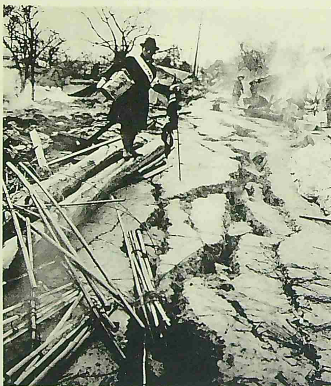
與謝郡市場村道路龜裂狀況 第二
