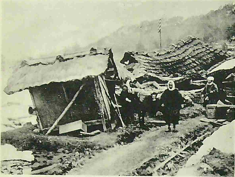
竹野郡網野町倒壊家屋状況
