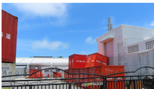
横ずれしたコンテナ (宮古島市 5/28 気象台職員撮影)
