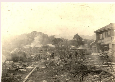
伊東海岸津波の跡
