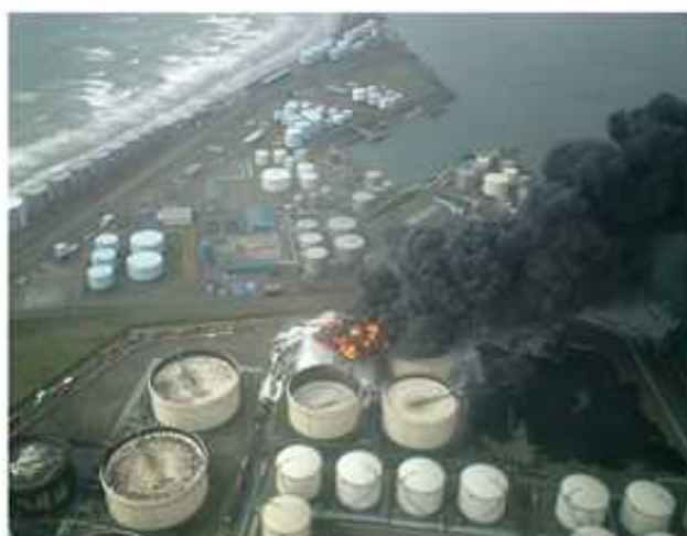
【スロッシングにより火災が発生した石油タンク】
