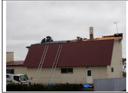
⑥屋根が飛散した住家
