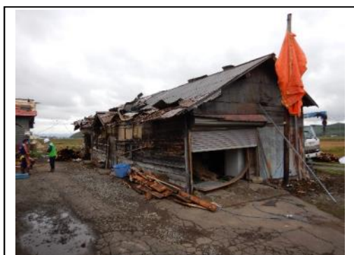
⑦破損した物置
