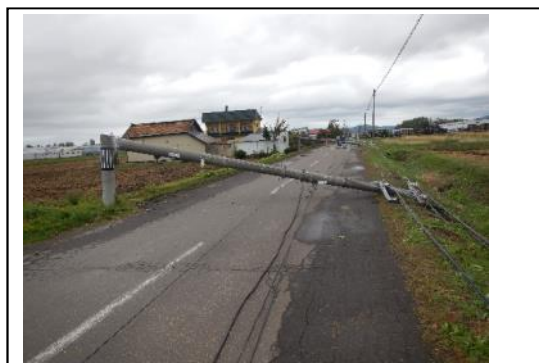
④電柱の折損
