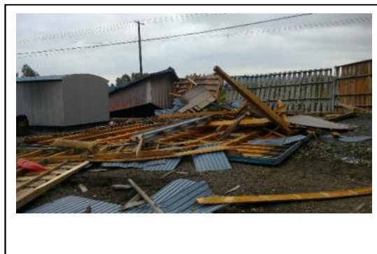
②倒壊した物置
