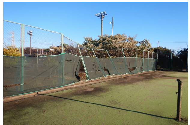
⑥ 一部損壊したフェンス (北西方向から撮影)
