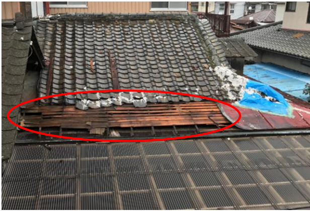
① トタンが飛散した住家 (南方向から撮影)
