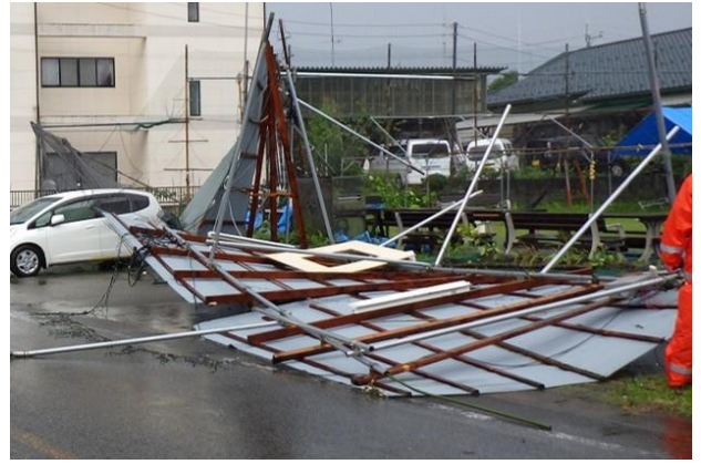
② 倒壊した仮設フェンス (東方向から撮影)
