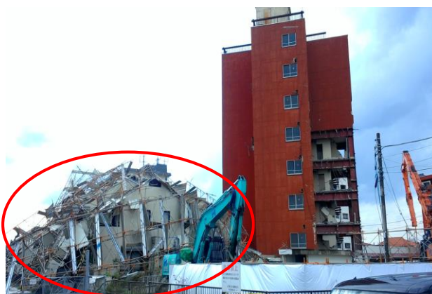
⑤ 倒壊した工事現場の足場 (南東方向から撮影)
