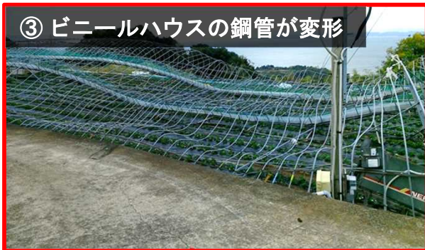
④ ビニールハウスの鋼管が変形
