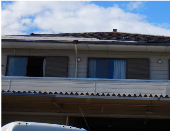
写真①屋根ふき材がはく離した店舗併用住宅 (南方向から撮影)
