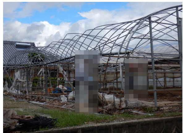
写真⑥倒壊したパイプハウス (南西方向から撮影)
