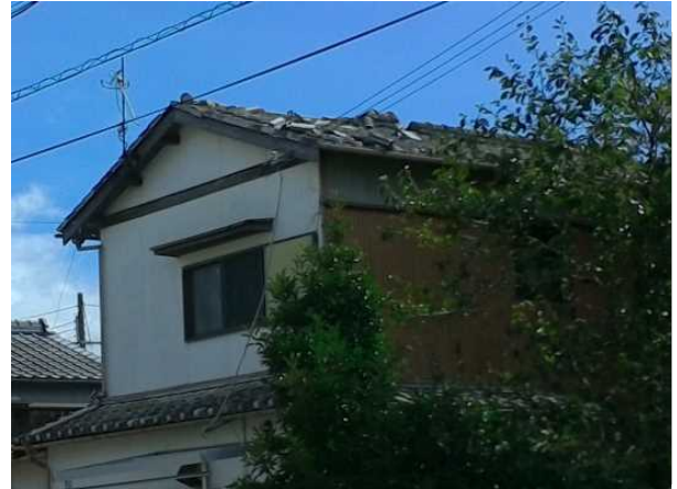
写真④屋根瓦が剥がれた木造住家 (北方向から撮影)
