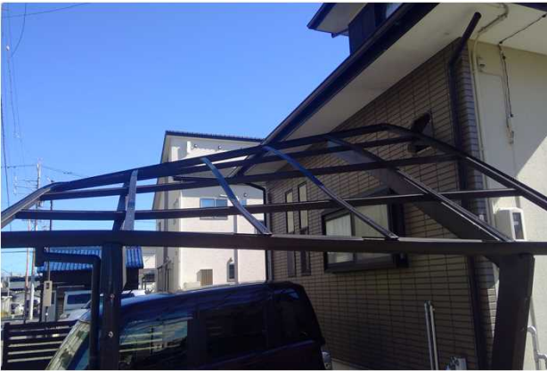
① 屋根のパネルが破損したカーポート (北西方向から撮影)
