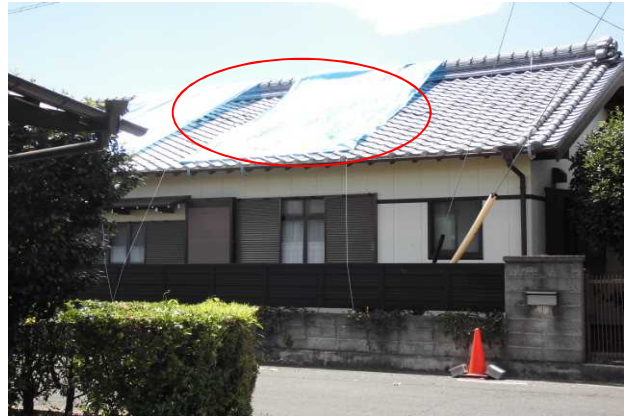
④ 屋根の瓦がめくれた住家 (東方向から撮影)
