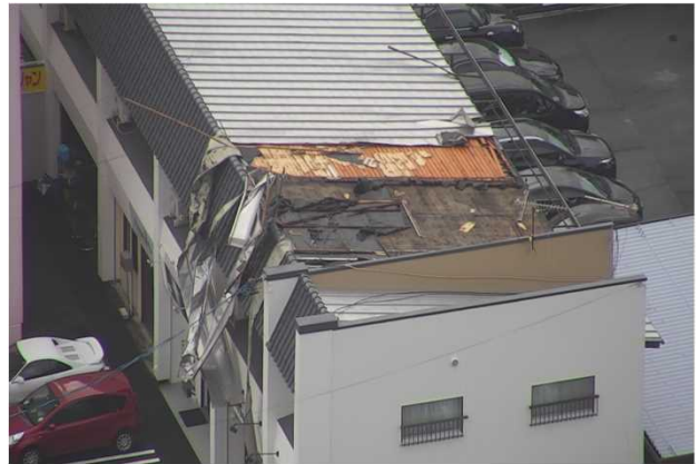
② 屋根のトタンがめくれた店舗 (北西方向から撮影、豊川市防災対策課提供)
