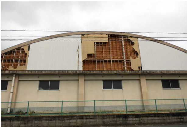
③ 外壁がめくれた体育館 (西方向から撮影)
