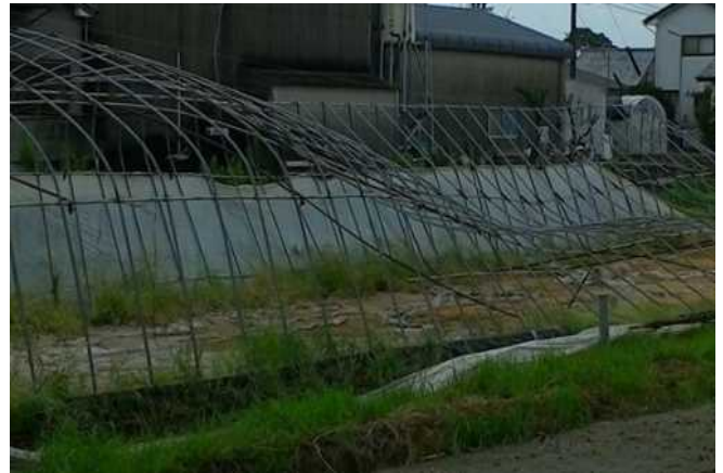
②鋼管が変形したパイプハウス
