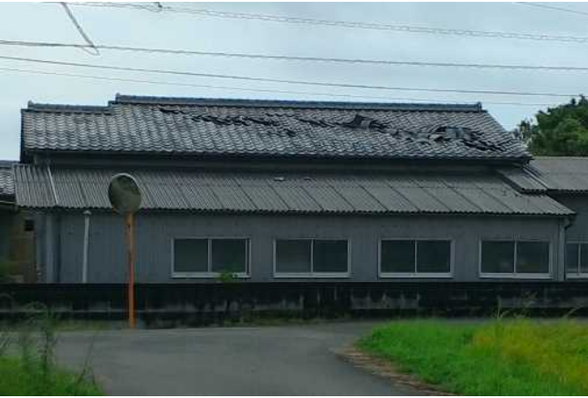
①屋根瓦がめくれた住家
