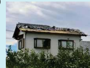
突風被害例 (住家の屋根瓦の飛散)
