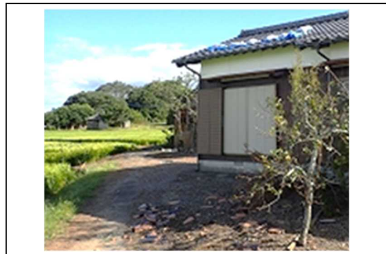
④ 屋根瓦の一部が飛散した住家 （北西から撮影）
