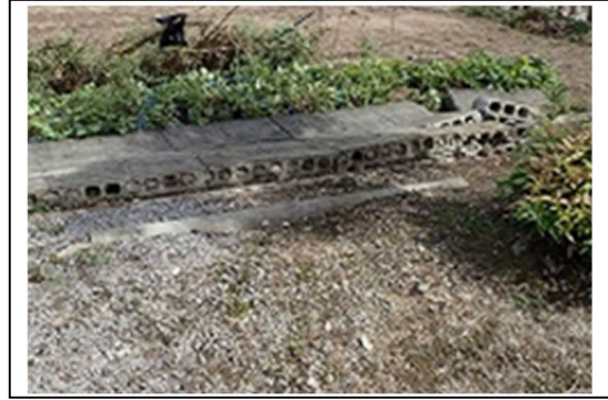
② 倒れたブロック塀（西から撮影）
