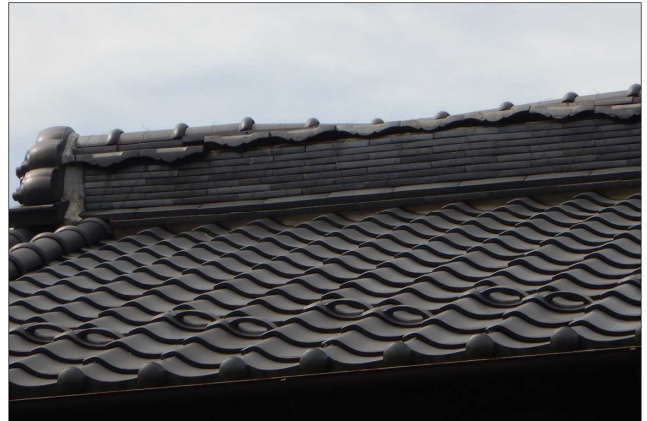
④ 棟瓦がずれた住家 (西方向から撮影)
