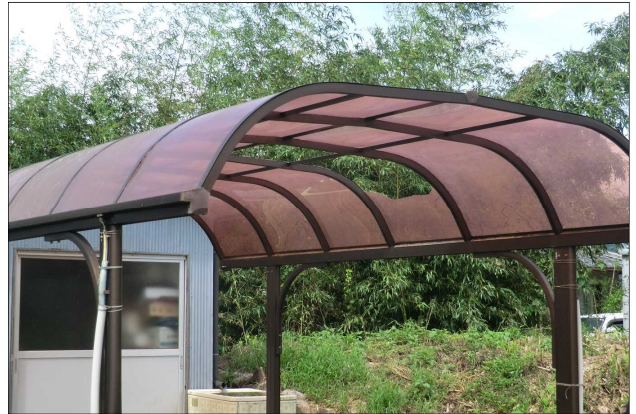
② 屋根が破損したカーポート (南方向から撮影)
