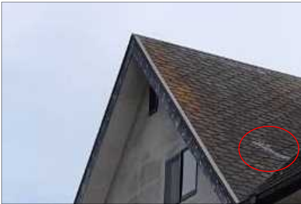
③ 屋根のスレートがめくれた住家 (南方向から撮影)
