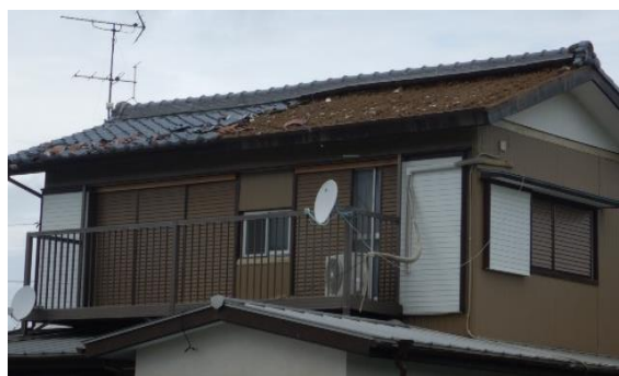
⑤ 屋根瓦が飛散した住家 (南東方向から撮影)
