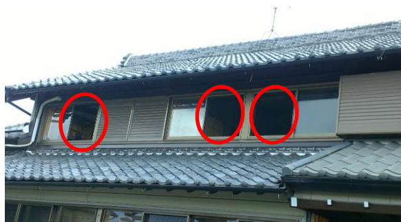
② 窓ガラスが割れた住家 (南東方向から撮影。 割れた窓ガラスはすでに撤去済み)
