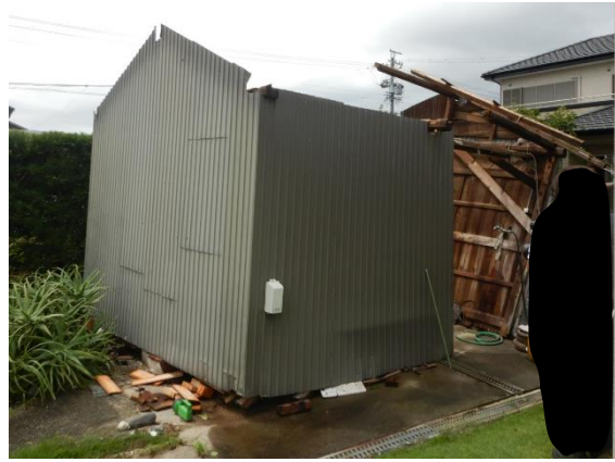
④ 変形した作業小屋 (北東方向から撮影)
