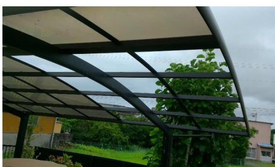
⑥ パネルが飛散したカーポート (南方向から撮影)
