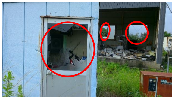
① 窓ガラスが割れた倉庫 (南方向から撮影)
