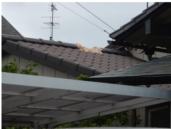
③ 屋根瓦がめくれた住家 (北東方向から撮影)
