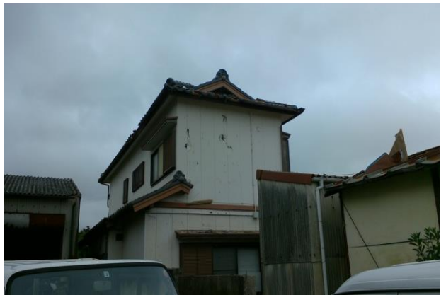
② 屋根瓦がめくれ、飛散物によって壁に 穴のあいた住家 (西方向から撮影)
