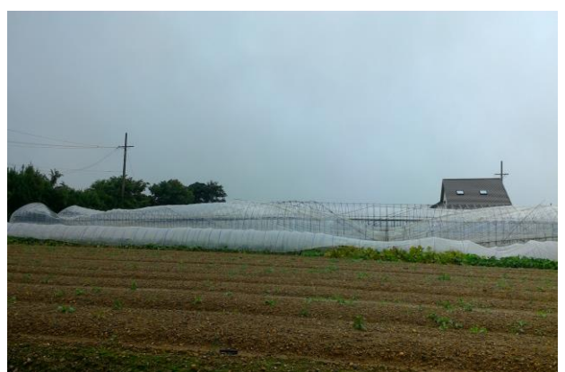
⑥ 鋼管が変形し被覆材が破れたビ ニールハウス (北東方向から撮影)
