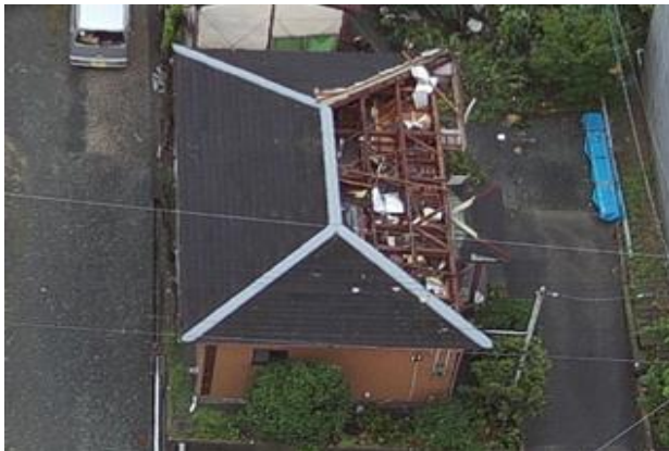
① 屋根が飛散した住家 (西南西方向の上空から撮影)
