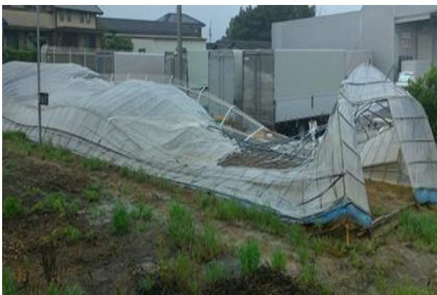
⑤ 鋼管が変形し被覆材が破れたビ ニールハウス (南西方向から撮影)
