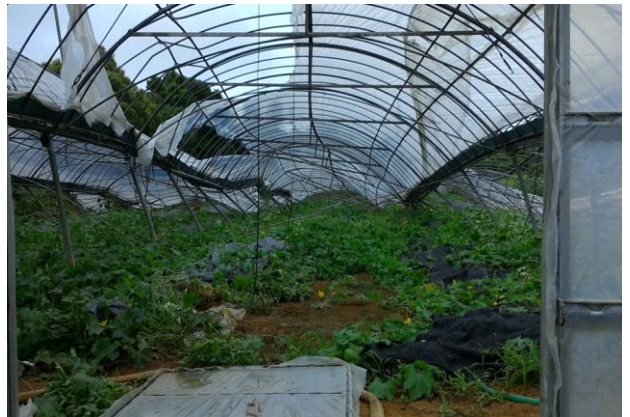
④ 鋼管が変形し被覆材が破れたビ ニールハウス (北北西方向から撮影)
