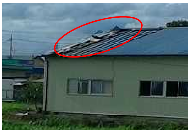
①-3 トタン屋根が飛散した工場 （南東から撮影）
