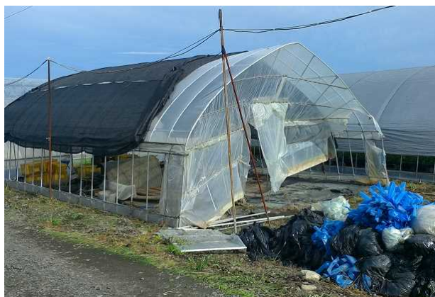
③-4 鋼管が変形したパイプハウス （北西から撮影）
