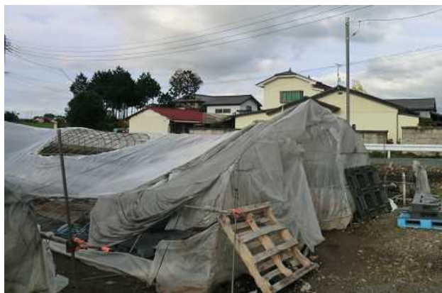
③-1 鋼管が変形したパイプハウス （西から撮影）
