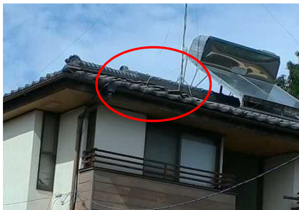
①-8 屋根瓦がめくれた住家 (南西から撮影)
