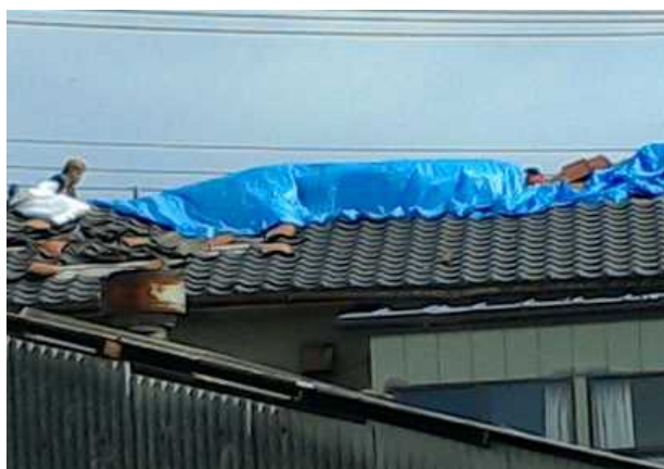
①-2 屋根瓦が飛散した住家 （①-1と同じ住家、北西から撮影）
