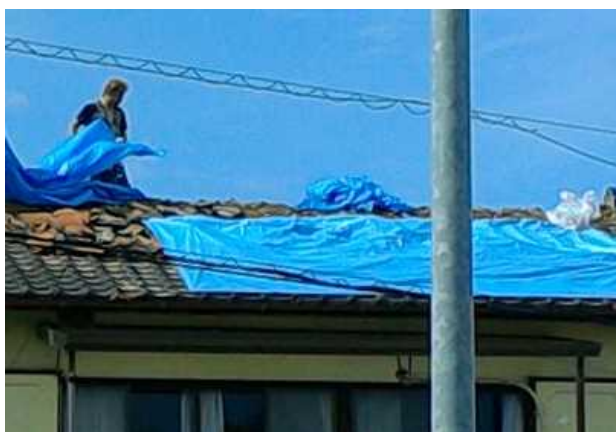
①-1 屋根瓦が飛散した住家 （南東から撮影）
