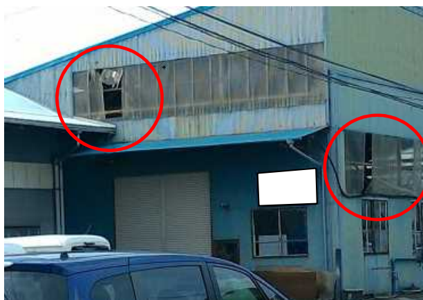
①-4 プラスチック波板がめくれた工場 （南東から撮影）
