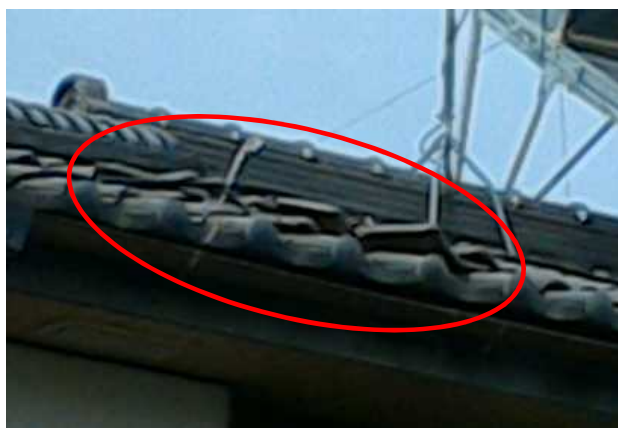
①-9 屋根瓦がめくれた住家 (①-8の拡大、南西から撮影)
