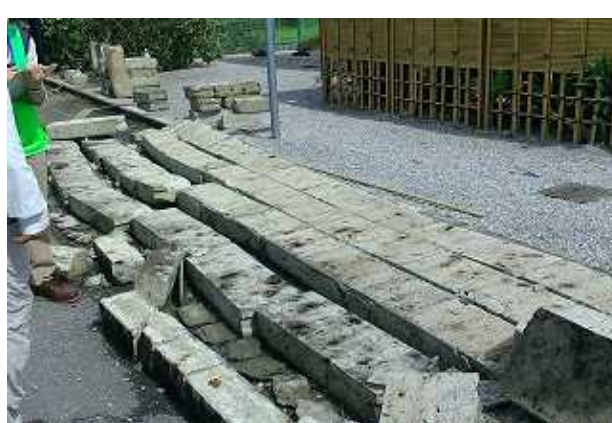
①-6 倒壊した石塀 （北西から撮影）
