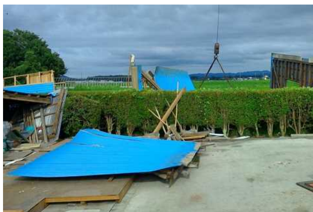
③-3 飛散した車庫（西から撮影）
