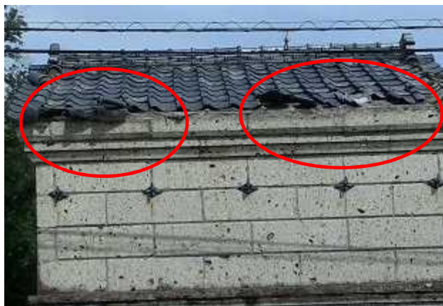
①-7 屋根瓦がめくれた蔵 (西から撮影)
