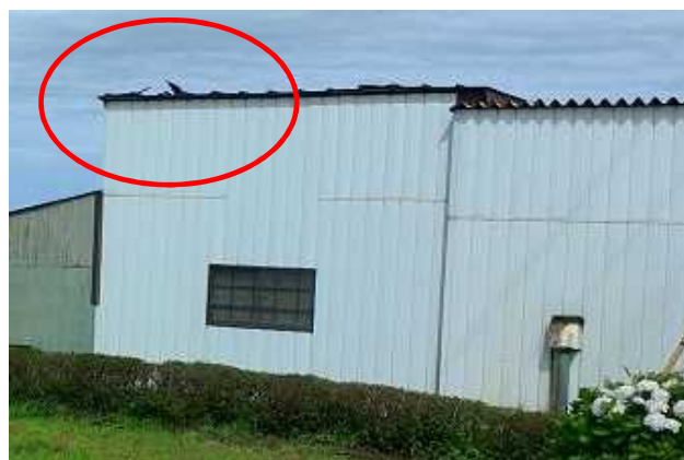
①-10 トタン屋根がめくれた倉庫 (西から撮影)
