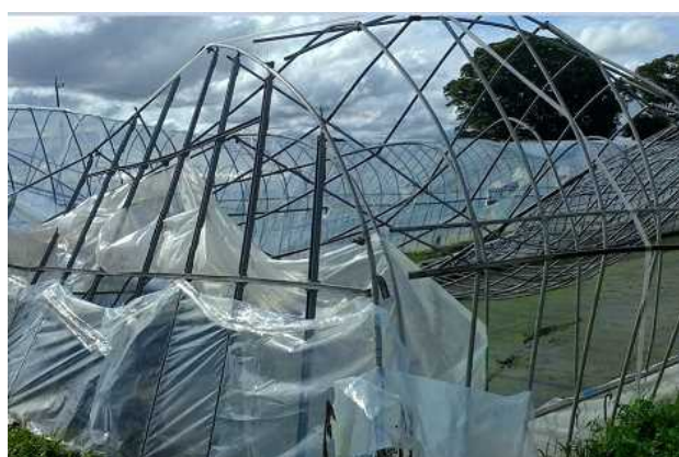
③-5 鋼管が変形したパイプハウス （南東から撮影）
