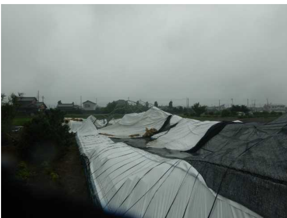
⑤ 変形したパイプハウス (南方向から撮影)
