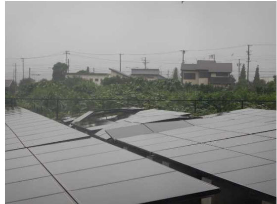
② めくれた太陽光パネル (東南東方向から撮影)
