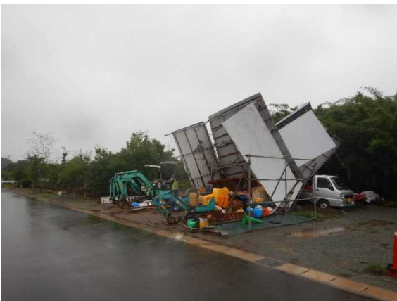
③ 倒壊した重機のプレハブ小屋 (東南東方向から撮影)
