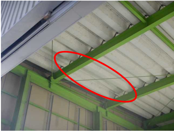
⑦ 屋根が変形した店舗のガレージ (南東方向から撮影)
