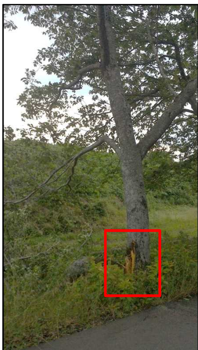
① 枝が折損した樹木 (南西方向から撮影)
