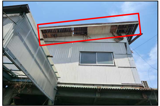
② 屋根材が剥離した住家 (南西方向から撮影)
