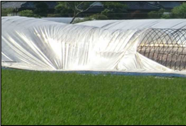
① 変形したパイプハウス (南西方向から撮影)
