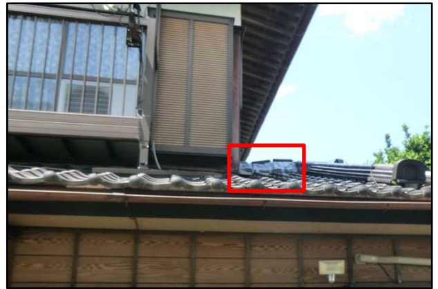
④ 屋根瓦が一部浮き上がった住家 (南方向から撮影)
