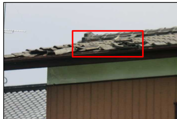
⑤ 屋根瓦が一部浮き上がった住家 (北西方向から撮影)
