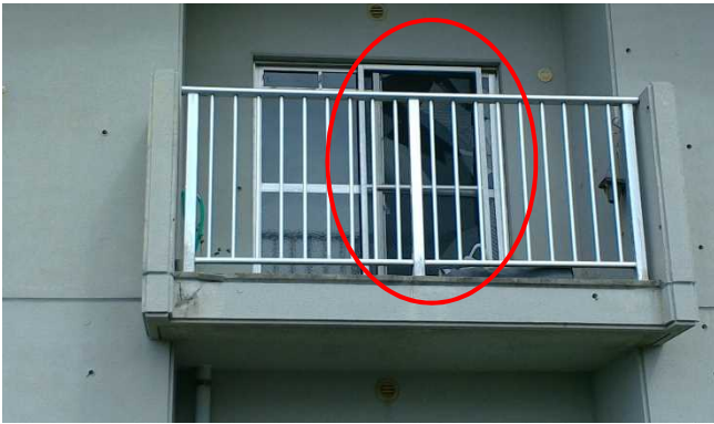
①窓ガラスが破損した鉄筋コンクリート造の集合住宅
