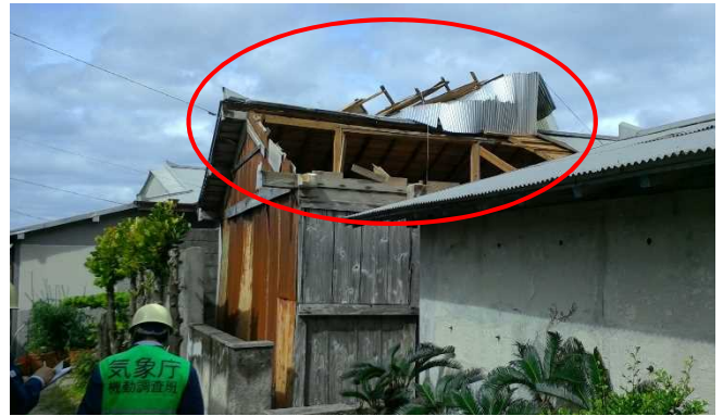
②比較的広い範囲で金属板ぶきの屋根がはく離した木造の非住家
