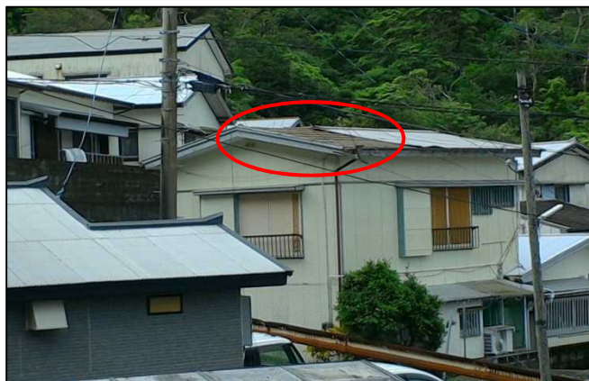
③金属板ぶきの屋根がはく離した木造の住家
