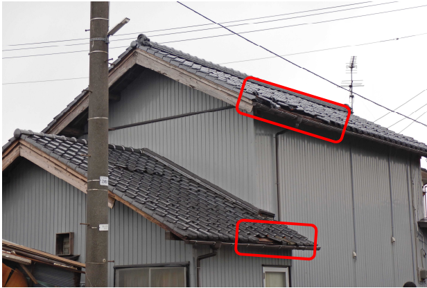
③ 屋根瓦が一部めくれた住家 （西方向から撮影）
