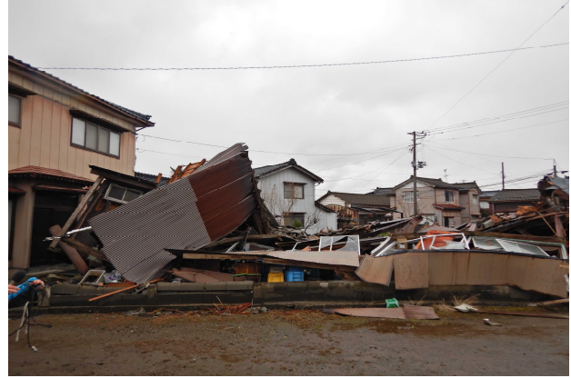
④ 倒壊した作業小屋 （南西方向から撮影）
