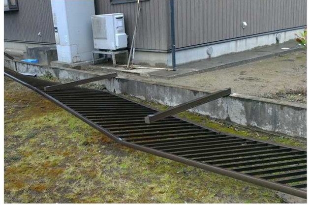
② 倒壊したフェンス （北方向から撮影）
