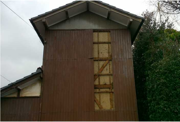
① 外壁のトタンがはがれた住家 （北東方向から撮影）
