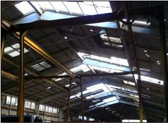
写真① 屋根ふき材が飛散した鉄骨造倉庫 (西方向から撮影)
