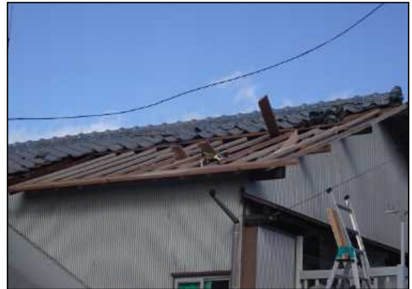
写真② 屋根の野地板が飛散した住家 (南方向から撮影)
