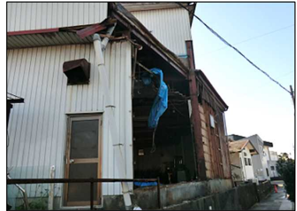
写真④ 外壁が剥がれた鉄骨造倉庫 (北東方向から撮影)
