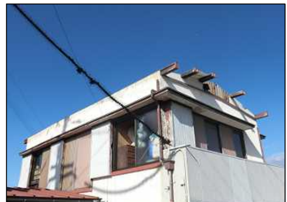
写真⑥ 小屋組の構成部材が飛散した住家 (南東方向から撮影)
