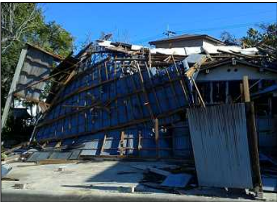
写真③ 倒壊した木造倉庫 (西方向から撮影)
