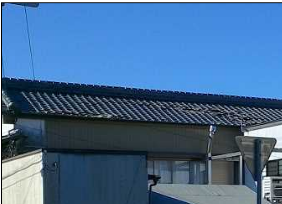
写真⑤ 屋根瓦がめくれた住家 (南東方向から撮影)
