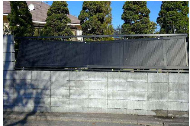
④ 倒壊したフェンス （南南西方向から撮影）
