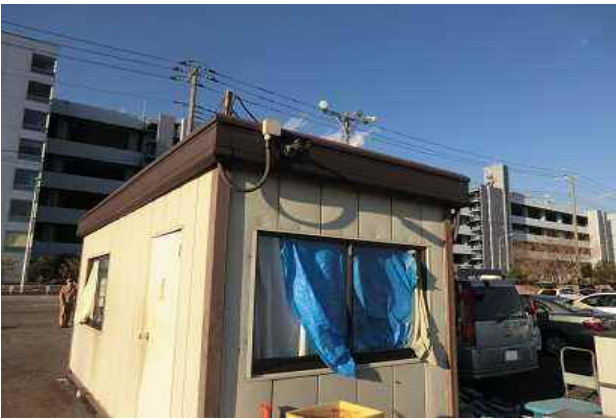
① 飛散物により窓ガラスが破損したプレハブ施設 （南南東方向から撮影）
