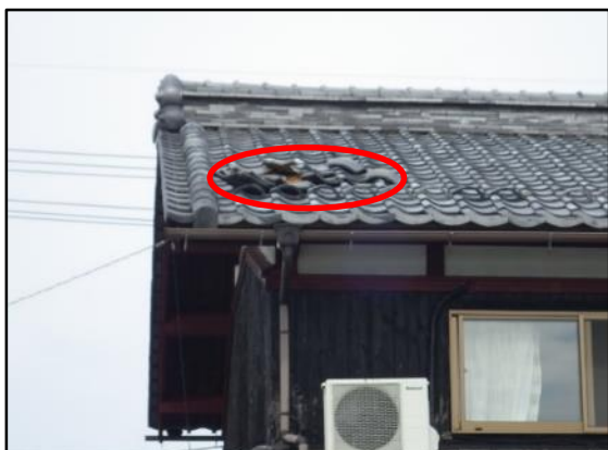
写真③ 屋根瓦が飛散した住家 (南方向から撮影)
