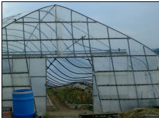
写真② 鋼管(直径22mm)が変形した園芸施設 (北方向から撮影)
