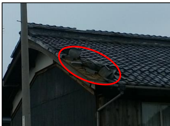
写真④ 屋根瓦が飛散した住家 (南方向から撮影)
