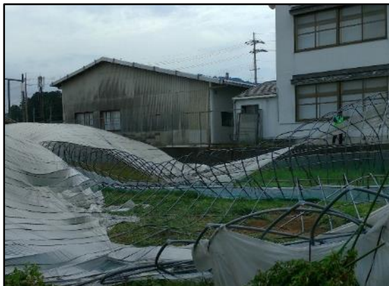
写真① 鋼管(直径26mm)が変形した園芸施設 (北東方向から撮影)
