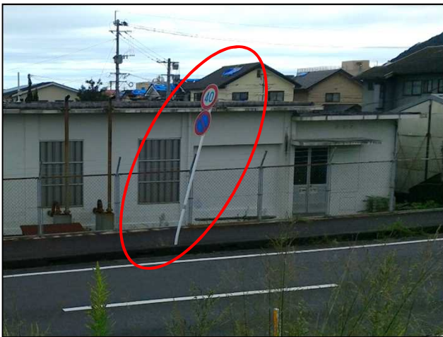
⑮傾倒した道路交通標識
