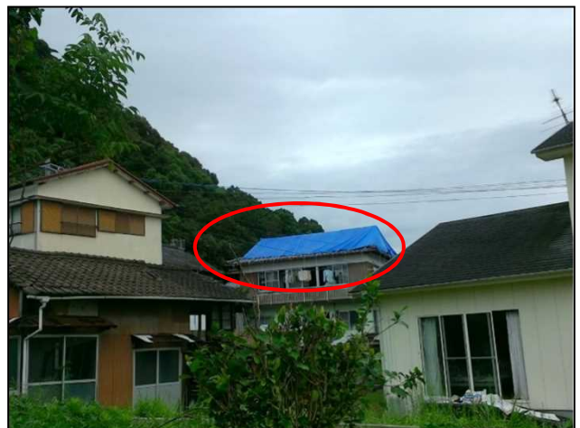
③⑩屋根が損傷した住宅
