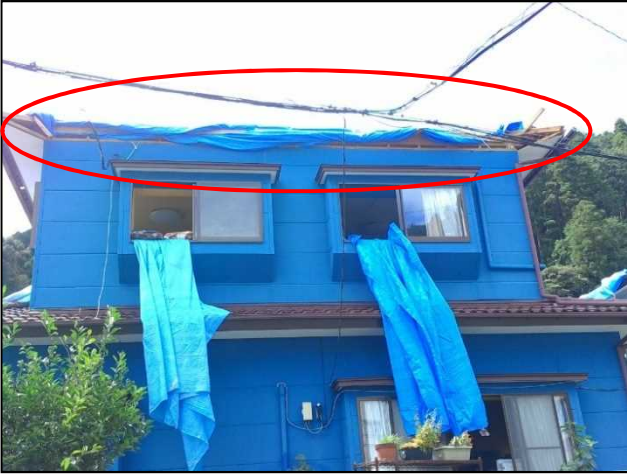
④③屋根が損傷した住宅
