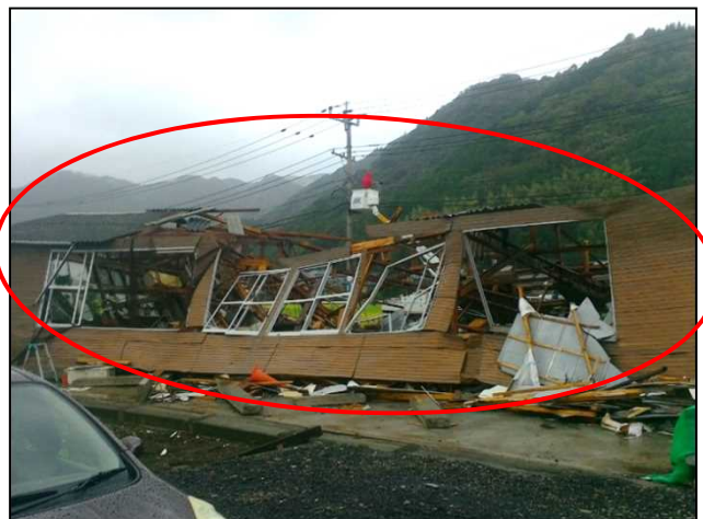
③⑥倒壊した非住家
