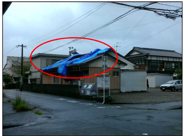
㉒屋根が損傷した住宅
