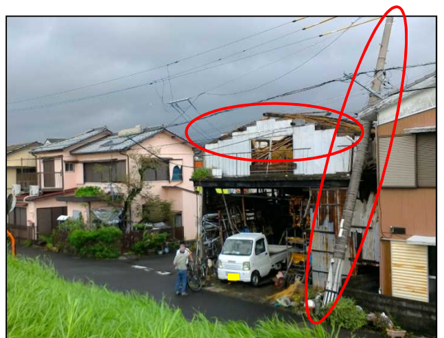
⑱屋根が損傷した倉庫及び折損した電柱
