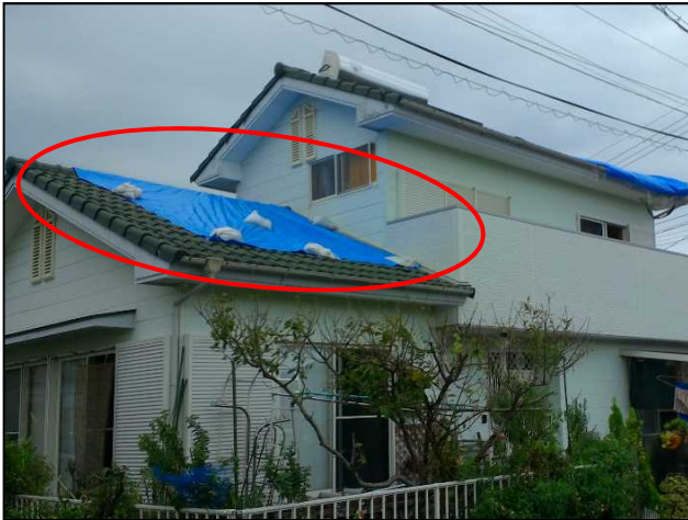
⑬屋根が損傷した住宅
