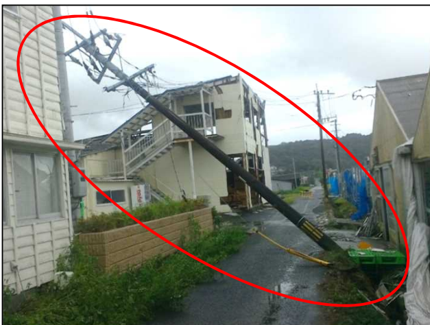
③⑤傾倒した電柱
