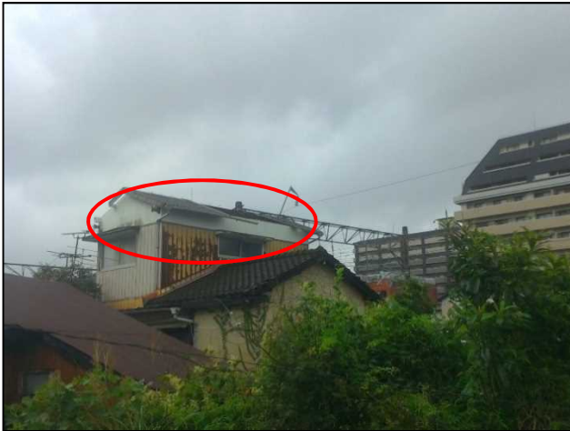
②⑤屋根が損傷した住宅
