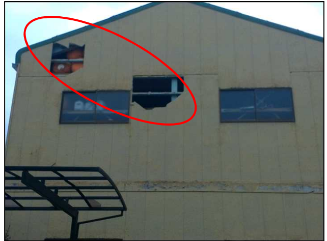
②外壁が損傷した倉庫
