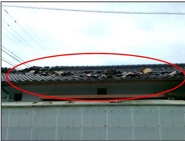
③⑨屋根が損傷した住宅
