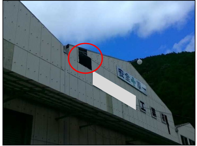
④④外壁が損傷した工場
