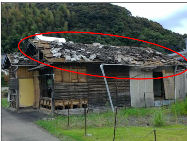
②⑨屋根が損傷した住宅
