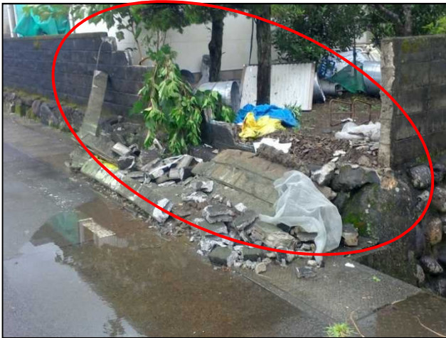
③⑦倒壊したブロック塀
