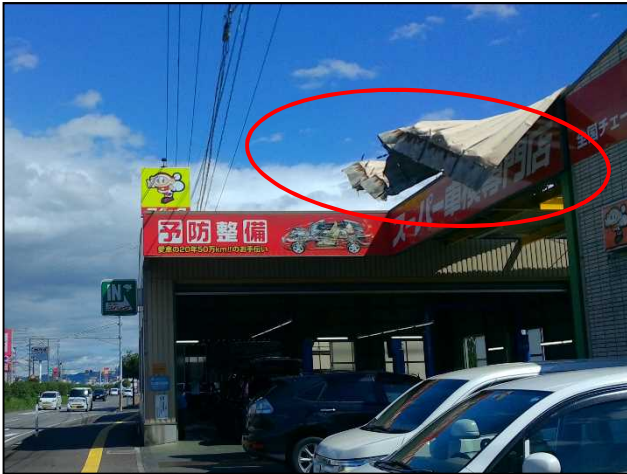
①屋根が損傷した店舗
