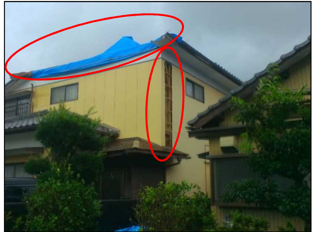
②⑥外壁・屋根が損傷した住宅
