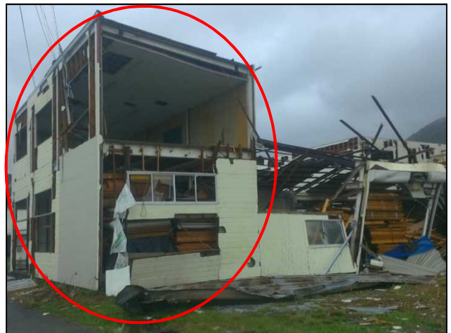
③④外壁が損傷した資材倉庫
