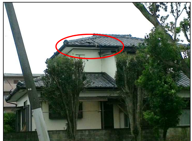
⑫屋根が損傷した住宅
