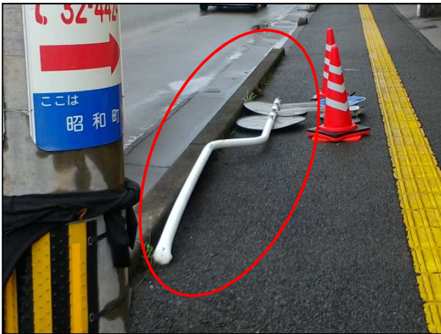
⑱倒壊した道路交通標識
