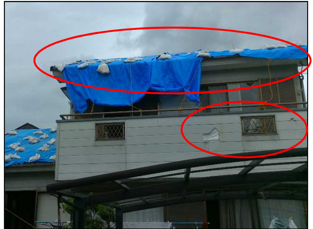
⑭外壁・屋根が損傷した住宅
