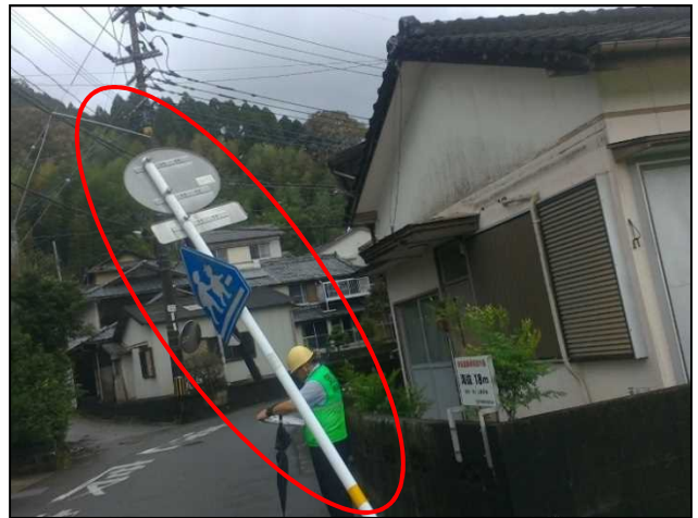
③⑧傾倒した道路交通標識
