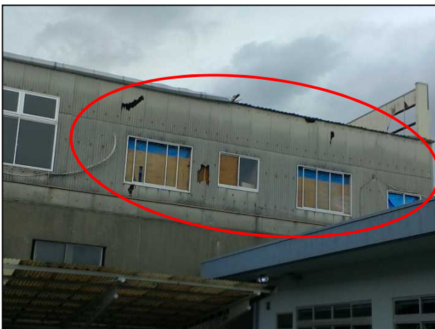
⑤外壁が損傷した倉庫
