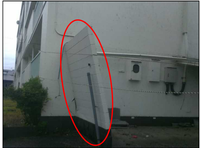
②⑧傾倒したブロック塀
