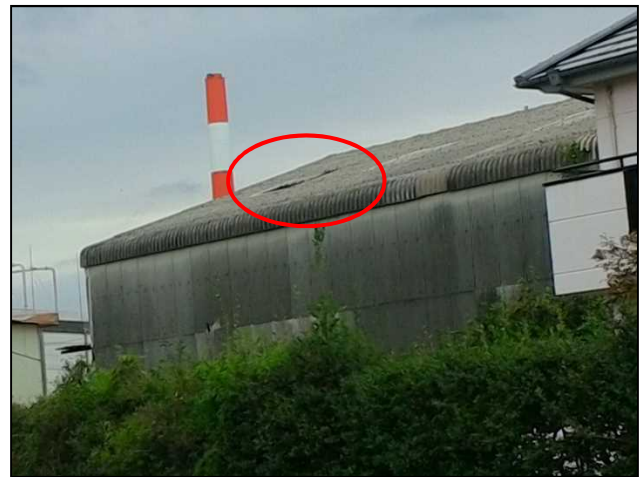
⑩屋根が損傷した倉庫
