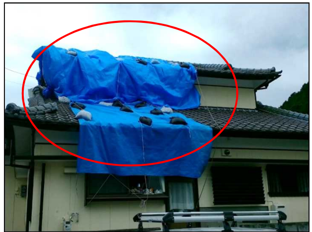
④⑩屋根が損傷した住宅
