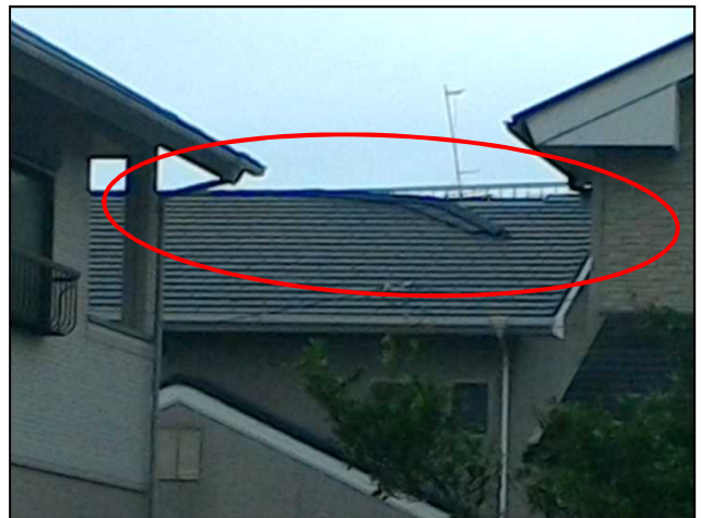
④屋根が損傷した住宅
