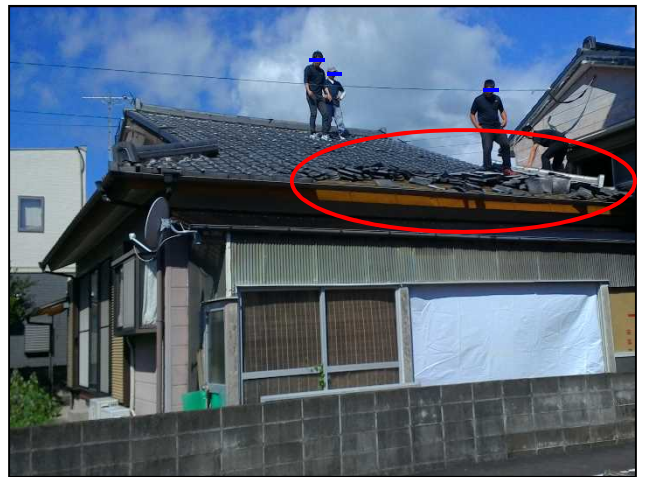
⑯屋根が損傷した住宅
