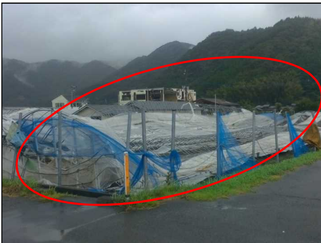
③③倒壊したビニールハウス
