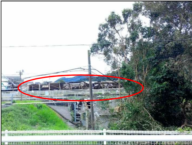
③①屋根が損傷した工場
