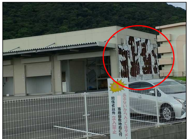
⑥外壁が損傷した倉庫
