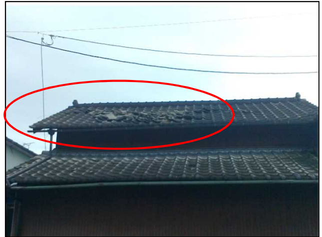
⑧屋根が損傷した住宅
