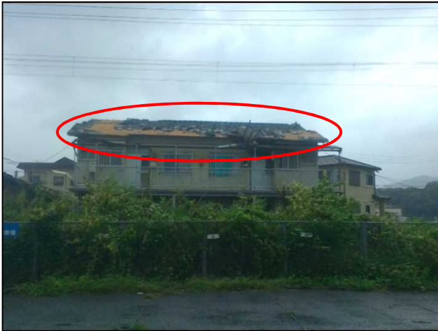
②⑦屋根が損傷した住宅
