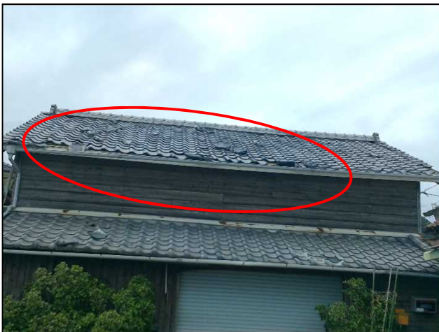
③屋根が損傷した住宅
