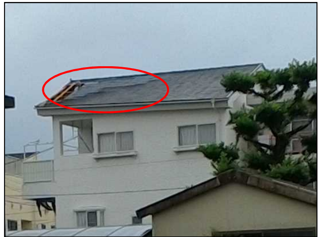
⑳屋根が損傷した住宅
