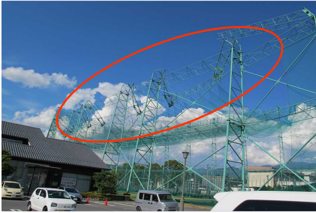
①ゴルフセンターの支柱の折損 （上田市常田）（西方向から撮影）
