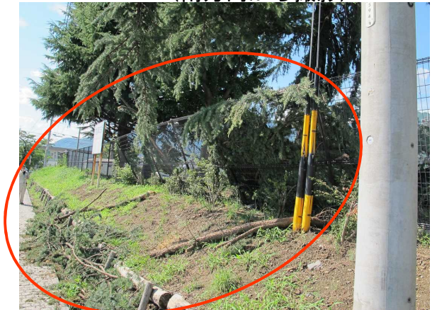
④鉄製フェンスの変形の原因となった枝折れ 上田市営球場外側からの写真 （上田市常磐城）（南方向から撮影）
