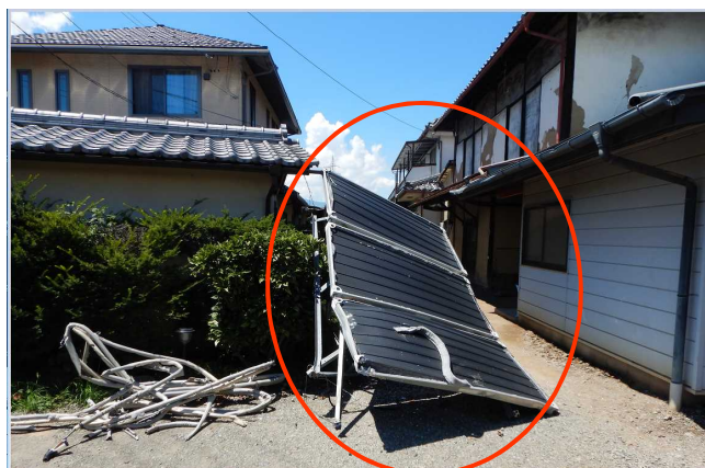
④パネルの飛散（2階屋根から落下） 上田市本郷（東方向から撮影）
