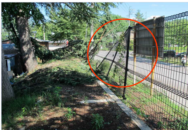
⑤枝折れによる鉄製フェンスの変形 上田市営球場内側からの写真 （上田市常磐城）（西方向から撮影）
