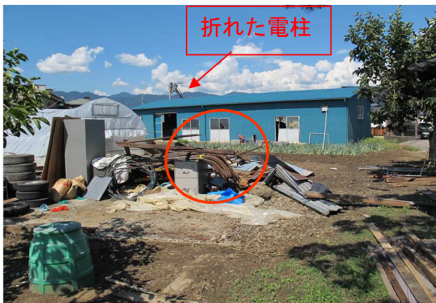
①物置小屋が飛散した跡地と部材 上田市小島（南方向から撮影）
