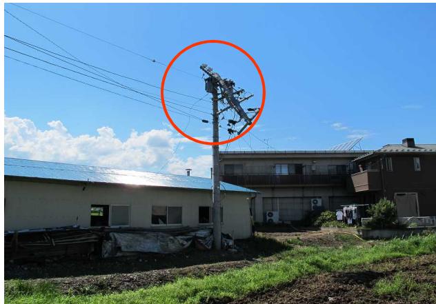
②折れた電柱※ 上田市小島（東方向から撮影） ※①にあった物置小屋が飛散しぶつかって 電柱が折れたと見られる。
