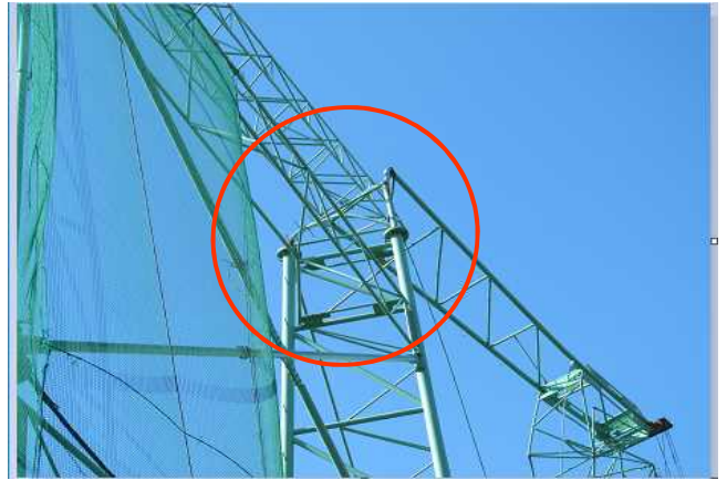
②ゴルフセンターの支柱の折損 拡大写真（上田市常田） （南方向から撮影）
