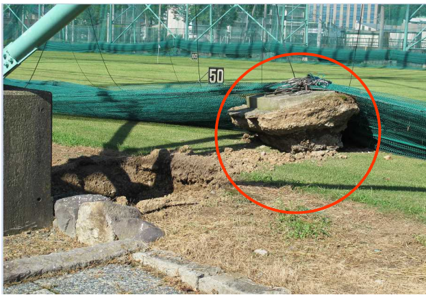
③ゴルフセンターのネットを押さえる 基礎コンクリートの移動（約2m） （上田市常田）（西方向から撮影）
