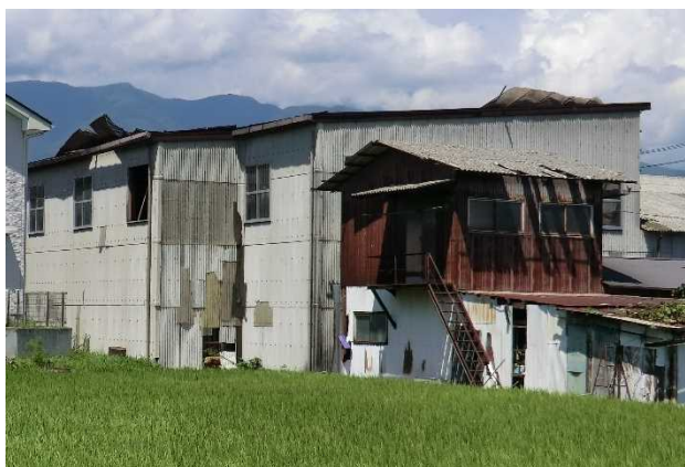
① 屋根が破損した工場（外観） （南東方向から撮影）
