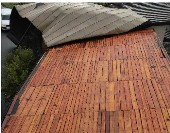
⑦ 屋根が剥がれた建物 (南方向から撮影)
