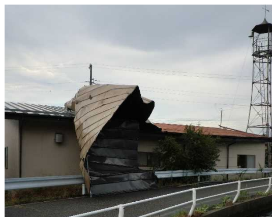
⑧ 屋根が剥がれた建物 (北西方向から撮影)
