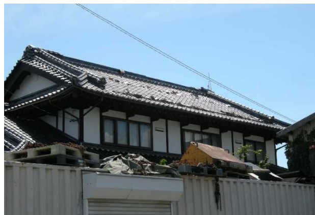
⑥ 屋根瓦が飛散した住家 （北西方向から撮影）
