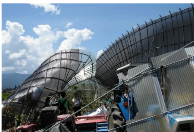
⑤ 変形した農業用ハウス （北東方向から撮影）
