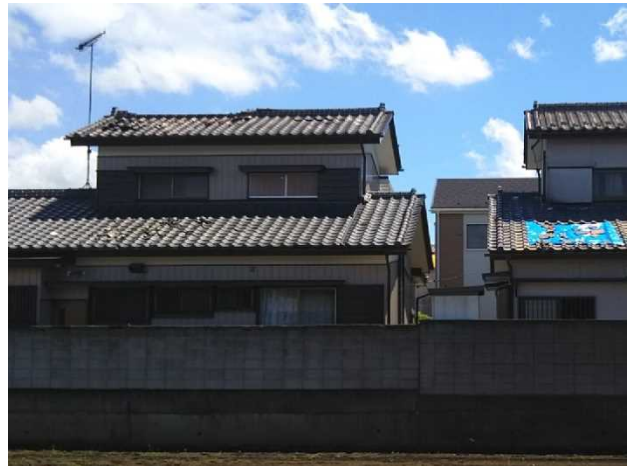
② 屋根瓦がめくれた住家 (北から撮影)
