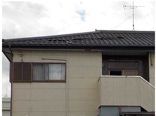
④ 屋根瓦がめくれた住家 (北から撮影)
