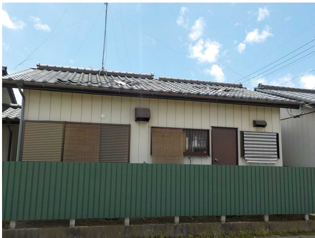
③ 屋根瓦がめくれた住家 (北から撮影)
