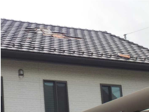
① 屋根瓦がめくれた住家 (北から撮影)
