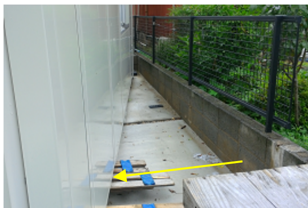
④ 固定されていないプレハブ倉庫の移動 (南方向から撮影)
